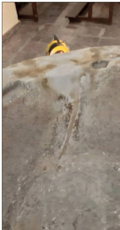
REJUNTADO Y RELLENADO DE LLAGAS RESULTANTES DEL PASO DE ADHERENCIA
